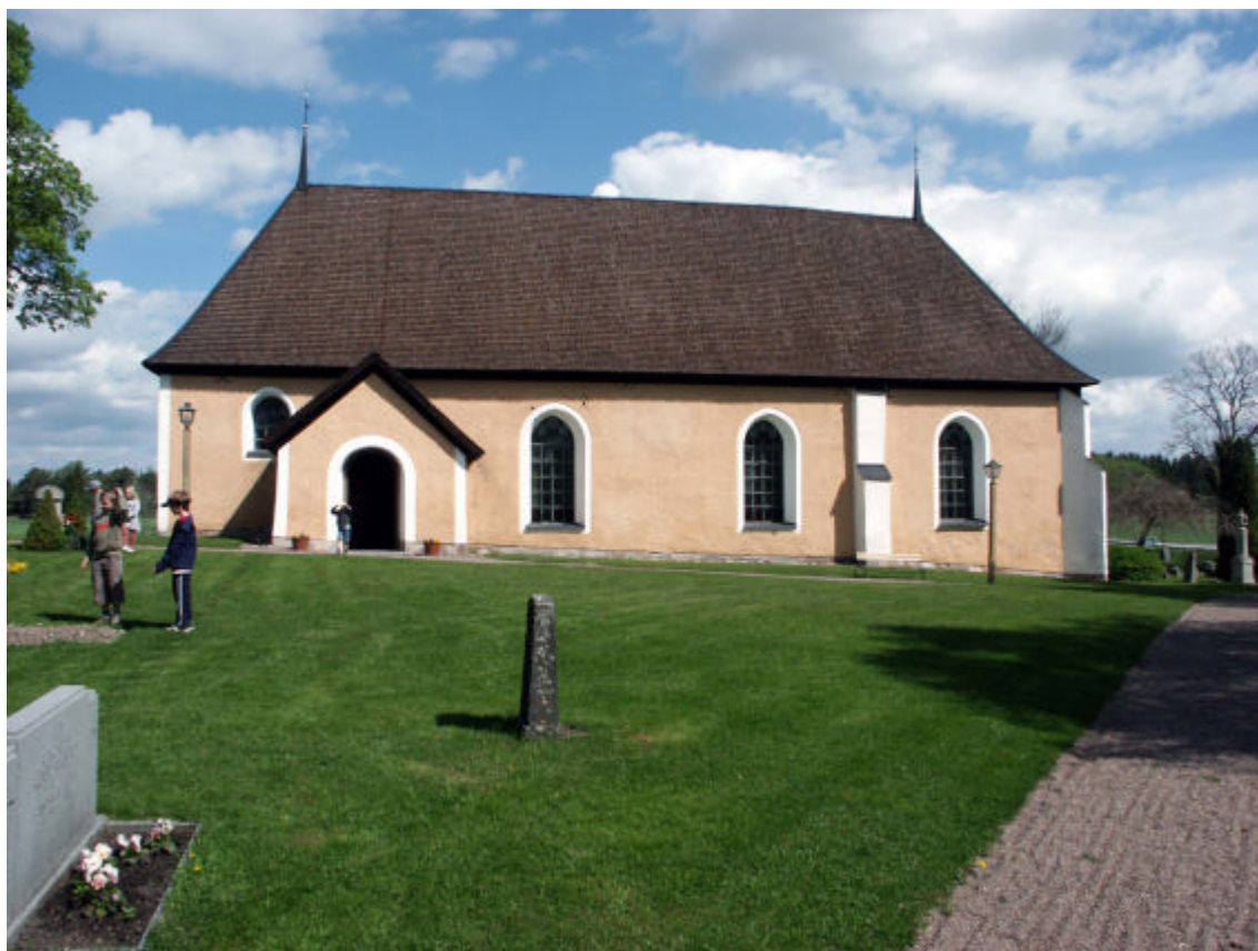
Kyrkan fick sin nuvarande karaktär vid en stor ombyggnad på 1660-talet då det medeltida långhuset förlängdes åt öster med ett nytt kor. Taket byggdes också om vid denna tid.
